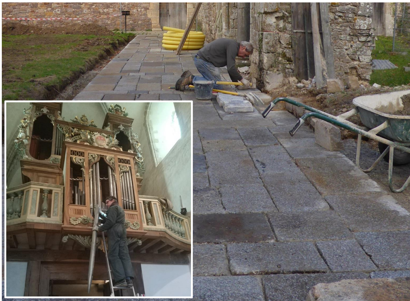
Abbaye de La Lucerne : restitution du dallage de la galerie Est du cloître en 2016 et relevage du grand orgue 2020.
