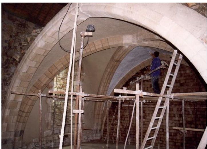
Juin 1999 : réalisation des enduits des voûtains, ici les 4 étapes sont visibles.
