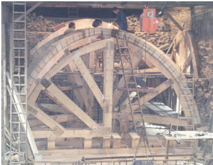
Scellement de la clé de voûte (avril 1999) et mise en place des joues Nord du gabarit de l'arc doubleau.
