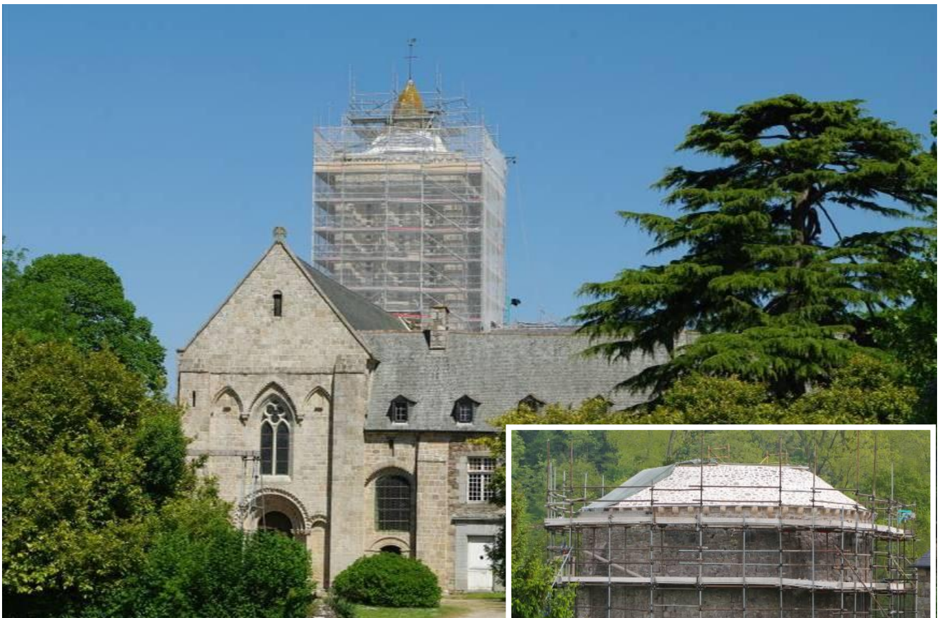
L'Abbaye de La Lucerne, restauration du clocher et du colombier, mai 2010.
